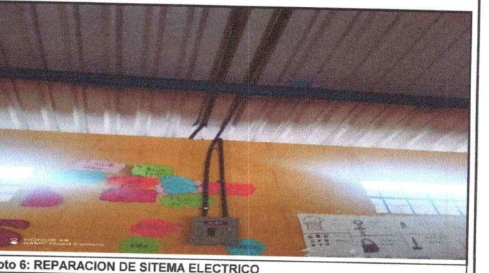
Foto 6: REPARACION DE SISTEMA ELECTRICO
