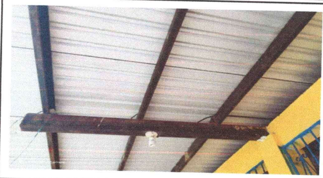
Foto 1: ESTRUCTURA DE TECHO
