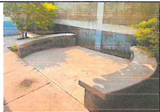
Foto 6: Colocación de piso cerámico en las banquetas
