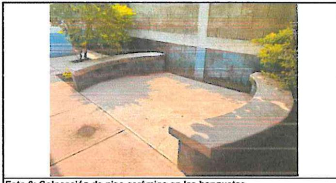
Foto 6: Colocación de piso cerámico en las banquetas
