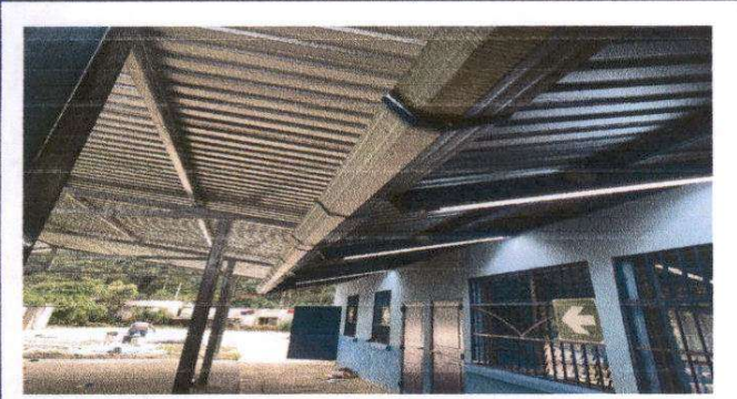
Foto 3: Sustitución de canal de metal
