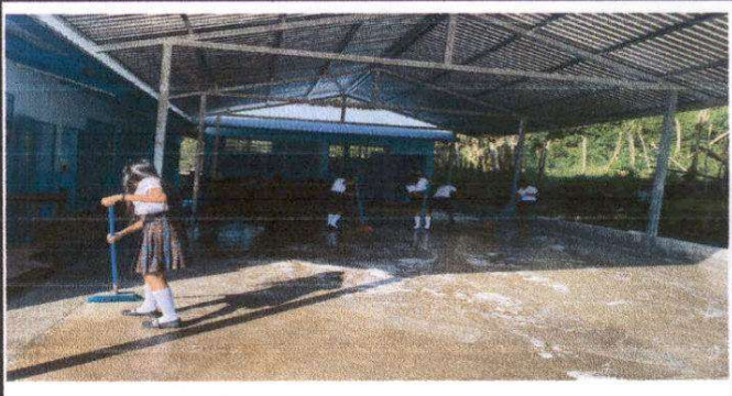
Foto 2: Sustitución de soporte de metal, por soporte de metal
