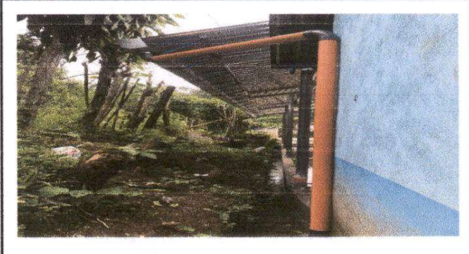
Foto 4: Sustitución de bajadas de agua pluvial (incluye accesorios)
