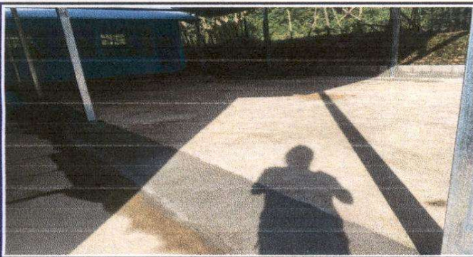
Foto 5: Sustitución de torta de concreto por torta de concreto de 10 centímetros de espesor
