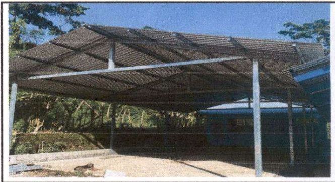
Foto 6: Sustitución de torta de concreto por torta de concreto de 10 centímetros de espesor
