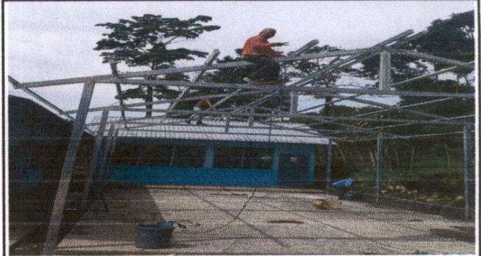
Foto 2: Sustitución de soporte de metal, por soporte de metal
