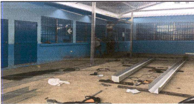
Foto 3: Sustitución de canal de metal
