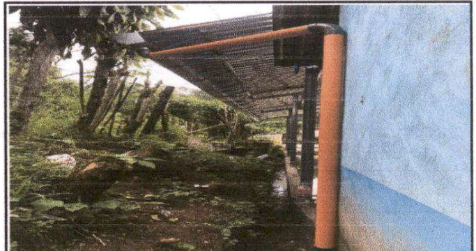
Foto 4: Sustitución de bajadas de agua pluvial (incluye accesorios)
