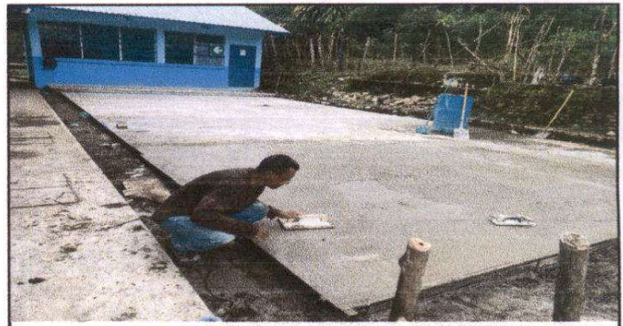
Foto 6: Sustitución de torta de concreto por torta de concreto de 10 centímetros de espesor
