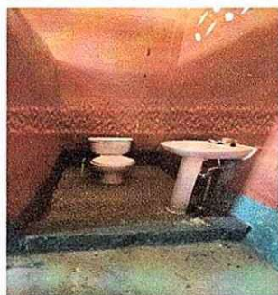
Foto 3: Modulo 2 Baños: Suministro Inodoro
