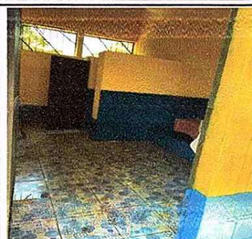
Foto 2: Reparación de red de drenaje y red de agua potable
