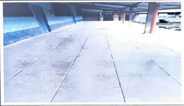
FOTO 2: CAMBIO DE PISO DE AULA Y CORREDOR
