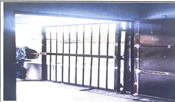
FOTO 3: PUERTA DE UN MODULO DE AULA
