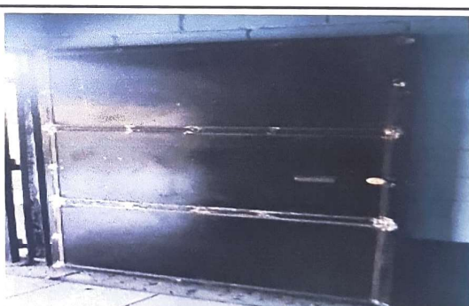
FOTO 4: PUERTA DE UN MODULO DE AULA
