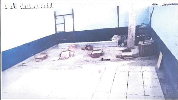
FOTO 1: CAMBIO DE PISO DE AULA Y CORREDOR
