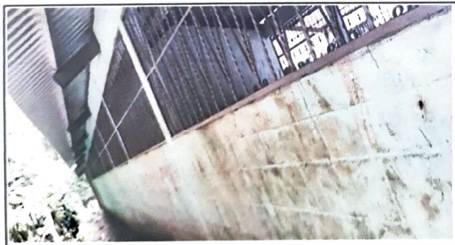
Foto 5: MANTENIMIENTO DE BALCONES Y REPELLO
