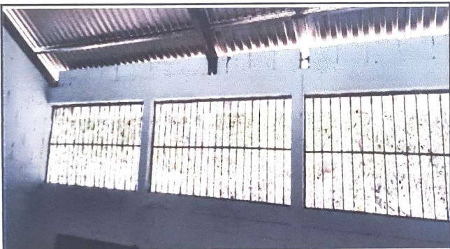
Foto 3: COLOCACION DE VENTANAS DE ALUMINIO
