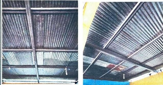
Foto1: Módulo 1, sustitución de lámina, por lámina troquelada aluzinc calibre 26. En el segundo nivel del modulo 2
