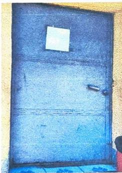
Foto 3: Módulo 2, sustitución de chapa, puerta de la cocina
