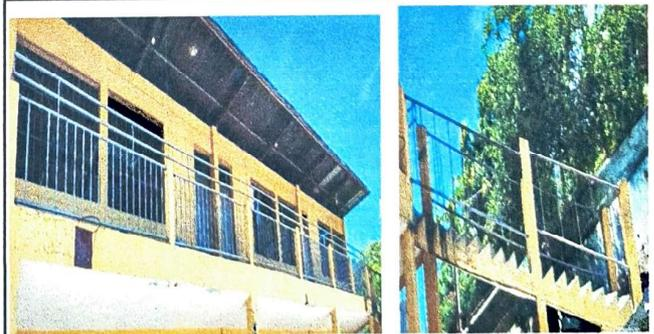
Foto 6: Módulo 4, sustitución de baranda de metal
