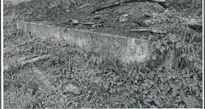
Mejoramiento en área de cocina
