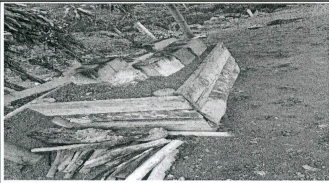
Sustitución de polletón
