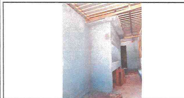
Foto 5: fabricación de canal de concreto para el polleton, en perímetro del polleton
