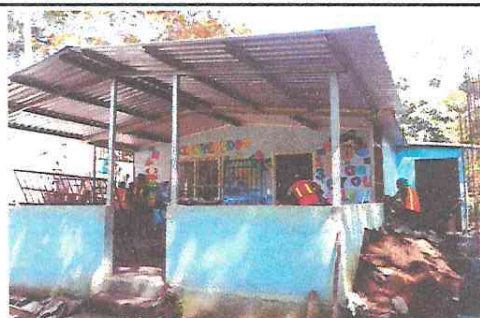
Foto 4: Sustitución de lámina, por lámina troquelada aluzinc calibre 26
