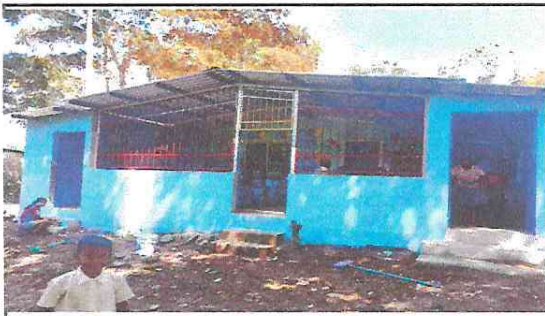
Foto 5: integracion de balcones
