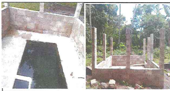
Foto 6: levantado de Block para el poso. Trabajado con material del proyecto pero mano de obra municipal
