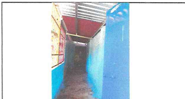
Foto 4: techo de bodega, la estructura de metal es material del proyecto, pero las láminas son reutilizadas, once metros cuadrados
