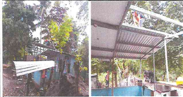
Foto 7: Sustitución de lámina, por lámina troquelada aluzinc 26
