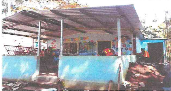
Foto 8: Sustitución de lámina, por lámina troquelada aluzinc 26
