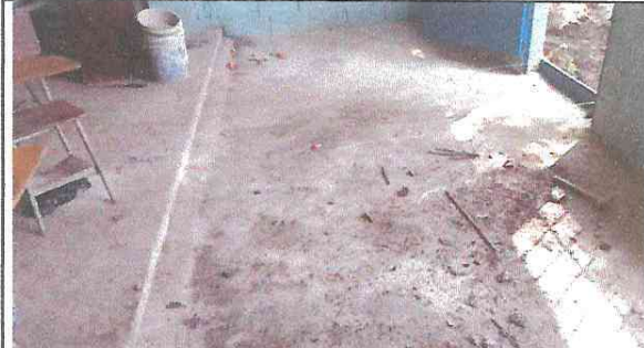
Foto 2: fundición de piso de aula, de catorce punto ochenta y dos metros cuadrados
