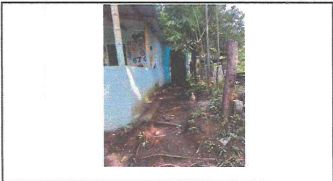
cambio de alambre de pua por muro de concreto y su torta de cemento
