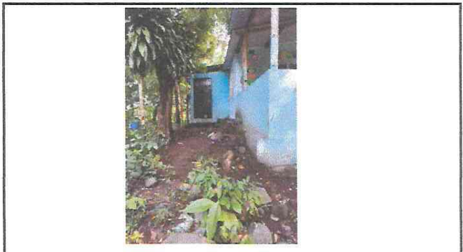
Ampliacion de cocina
