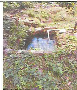
Foto 6: levantado de Block para el poso. Trabajado con material del proyecto pero mano de obra municipal
