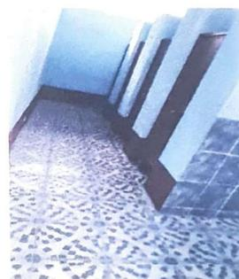
Foto 4: Pintura, colocación de puertas y piso cerámico en baños
