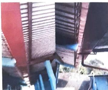
Foto 5: Finalización de instalación de canales
