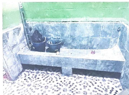
Foto 2: En proceso de reparación de mingitorio
