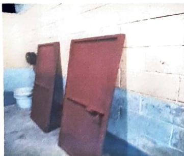
Foto 5: Fabricación de puertas para baños
