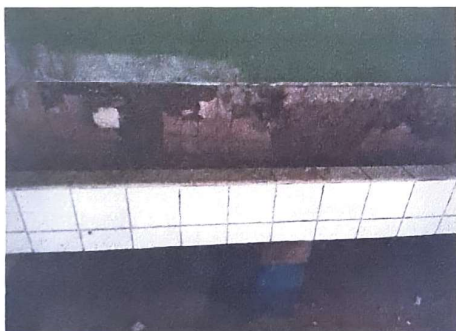
Foto 3: Instalación de tuberías y accesorios de lava manos que estaban en mal estado.
