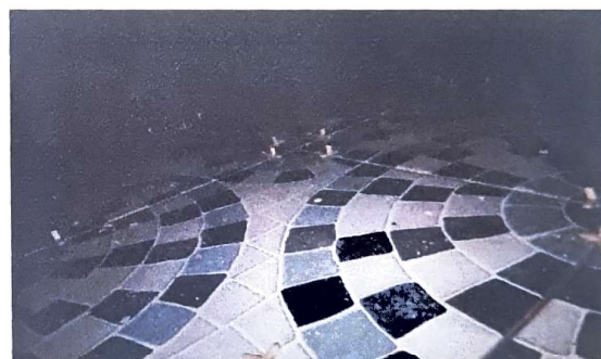
Foto 4: Colocación de piso cerámico
