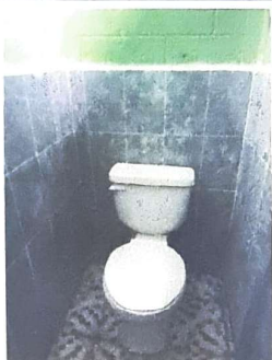
Foto 1: En proceso de instalación de sanitarios.
