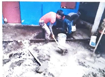
Foto 6: Proceso de Instalación de pilas y planchas de concreto en patio
