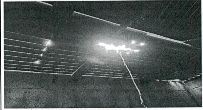
Sustitución de cubierta de lámina y estructura de soporte de madera por metal.
