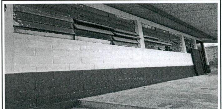
Sustitución de vidrios quebrados en ventanas tipo balcón e instalación de balcones en ventanas de un aula
