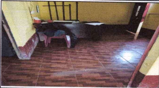
Foto 1: Finalización de piso en dirección.
