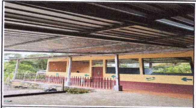
Foto 2: Finalización de techado en corredor.
