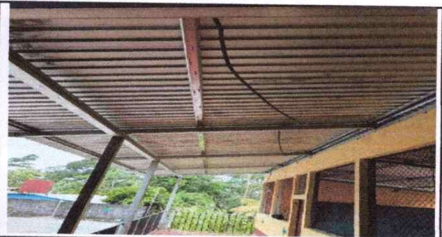
Foto 6: Finalización de techado.
