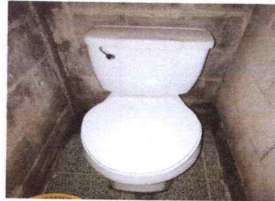
Foto 2: Finalización de colocación de tazas sanitarias.
