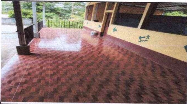
Foto 3: Finalización de piso en el corredor.
