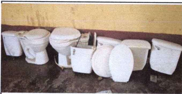
Foto 5: Extracción de baños sanitarios.
