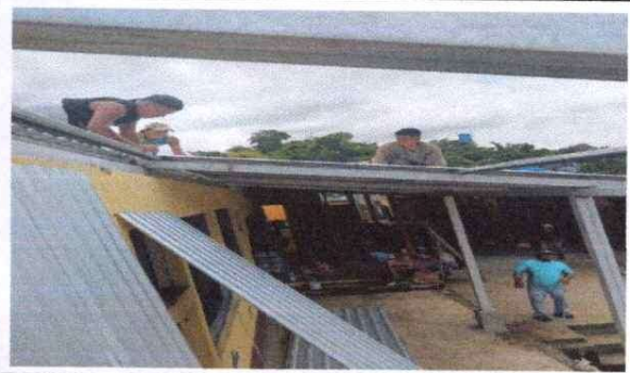
Foto 4: Avance de colocación de lámina en aulas y corredor.
