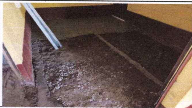
Foto 3: Avance de torta para piso en bodega.
