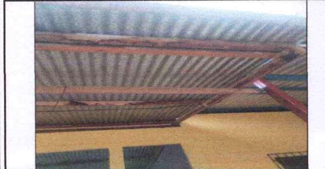
Foto 5: remodelación de costaneras.
