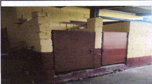
Foto1: remodelación de baños para niños.
