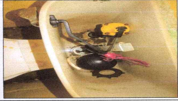
Foto 2: reparación de sanitarios.
