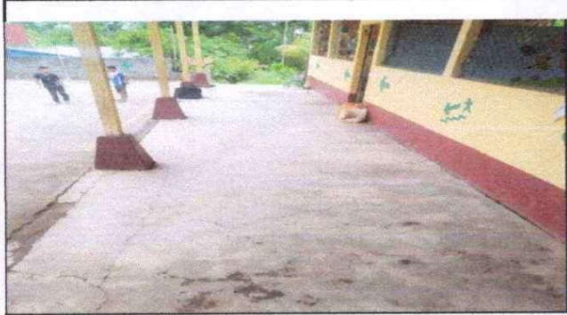
Foto 3: remodelación de piso.
