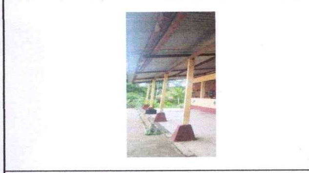
Foto 4: remodelación de parales.
