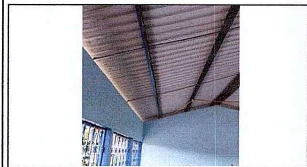
Foto 3: Pintura en interior de aulas y costaneras
