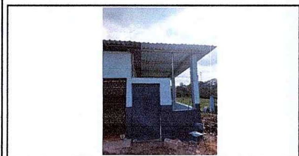
Foto 5: sustitución de techo en corredor de cocina
