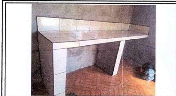
Foto1: suministro de mesa de concreto en cocina
