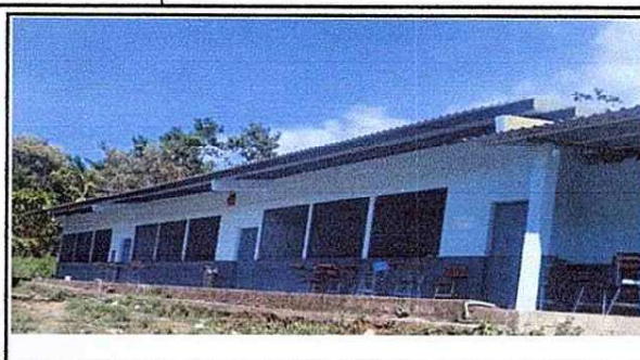
Foto 2: pintura en exterior de aulas
