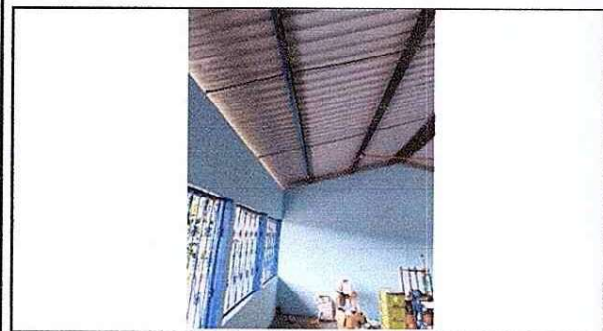
Foto 3: pintura en interior de aulas
