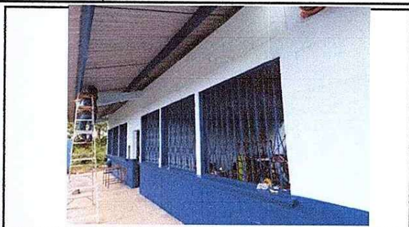
Foto 2: pintura exterior de aulas
