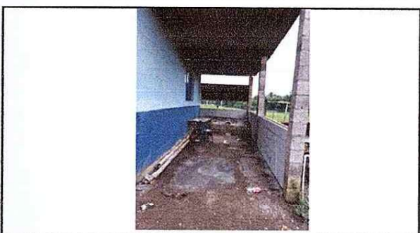
Foto 4: levantamiento de muro en corredor de cocina
