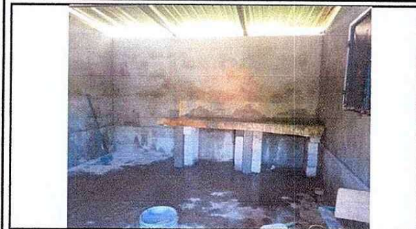
Foto1: suministro de mesa de concreto en cocina
