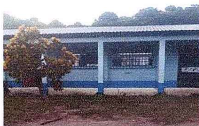
Foto 3: Balcones instalados en la superior de la escuela
