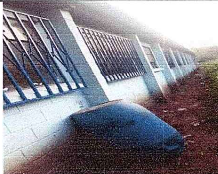
Foto 2: Balcones de metal ya instalados
