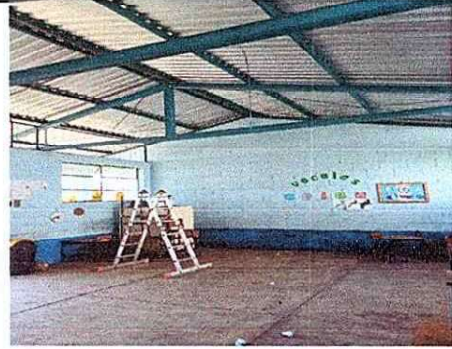
Foto 4 Instalacion de energia electrica
