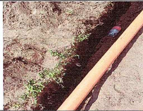
Foto 2: Instalación de tuberia para drenaje
