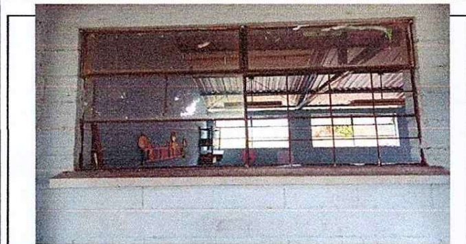
Foto 5: Colocacion de balcones en 40 ventanas
