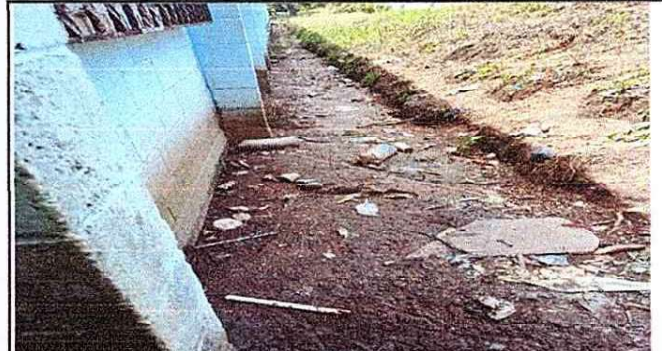
Foto 2: Instalacion de drenaje
