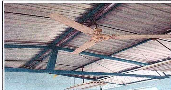
Foto 3: Reparacion cableado electrico
