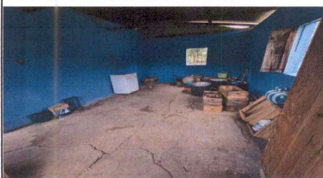
Foto 3: Sustitución de ventana por ventana de vidrio.
