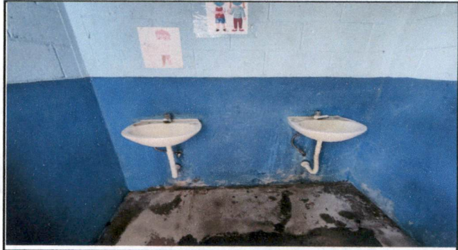
REPARACION DE LAVAMANOS, COLOCACION DE AZULEJO Y PINTURA
