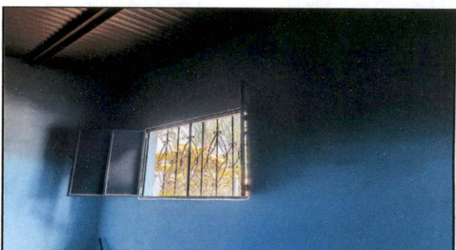
REPARACION EN BALCONES DE METAL
