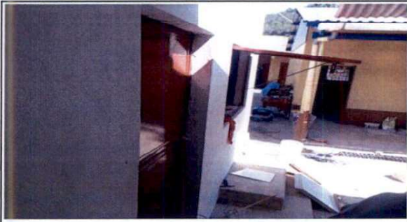
Foto 1: Repello de paredes, cambio de puerta y ventana, cambio de drenaje para la parte externa de la cocina y colocación de piso cerámico.
