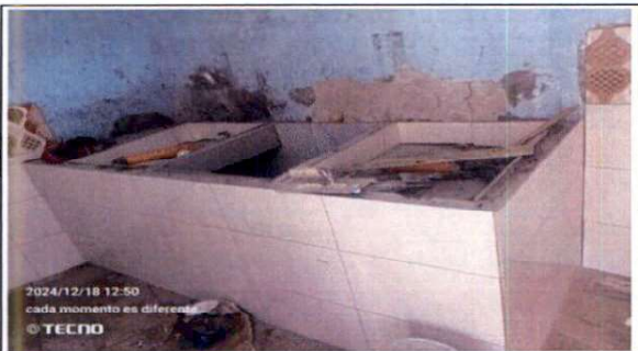
Foto 3: Cambio de cajas de registro de drenaje para la parte externa de la cocina y sustitución de pila tanque-pila.
