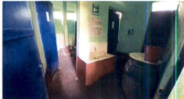
Foto 4: Colocación de piso cerámico, mejoramiento de tres puertas grandes, cuatro puertas pequeñas y colocación de azulejo en un lado de baño con sustitución de accesorios en un baño.
