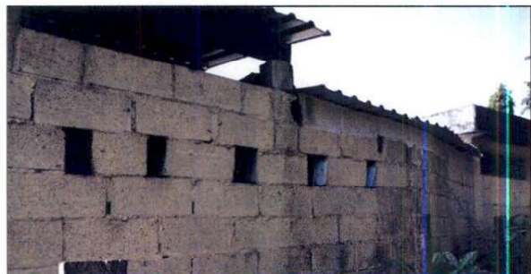
Foto 6: Repello de 2 lados de pared exterior de cocina .
