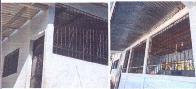
Foto1: Sustitución de malla por balcones en ventanas de aulas
