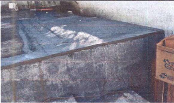
Foto 3: Reparación de fosa séptica
