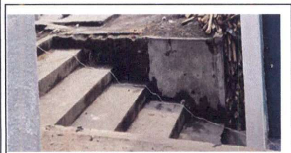
Foto 3: Reparación de fosa séptica
