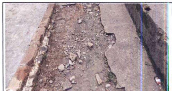
Foto 4: Reparación de plancha de concreto de patio
