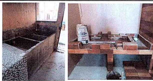
Foto 6: En el modulo de cocina se sustituirá el piso ceramico, tambien se realizara un pila grande con su azulejo y se cambiara el sistema electrico de la cocina.
