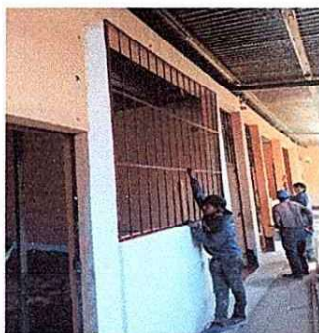
Foto 3: En esta parte se realizara una abertura y tallado de puerta de metal, y tallado de ventana con balcon.
