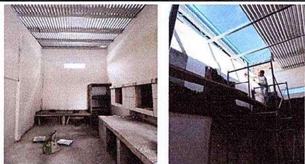
Foto 5: En esta parte se trabajara la demolición total y se trasladara para el fondo de la cocina, realizando un nuevo polleton para cocina con chimenea con tres discos. Y techado de cocina
