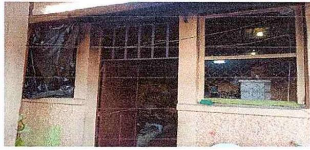
Foto 4: En el modulo de Cocina se trabajara sustitución de puerta de metal, ampliación de ventana con balcon, nivelación de pared para una sola caída, cambio de costanera de metal y de lamina troquelada de 29 pies.
