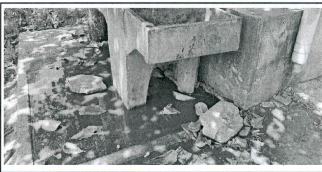
Sustitución de pila de dos lavaderos
