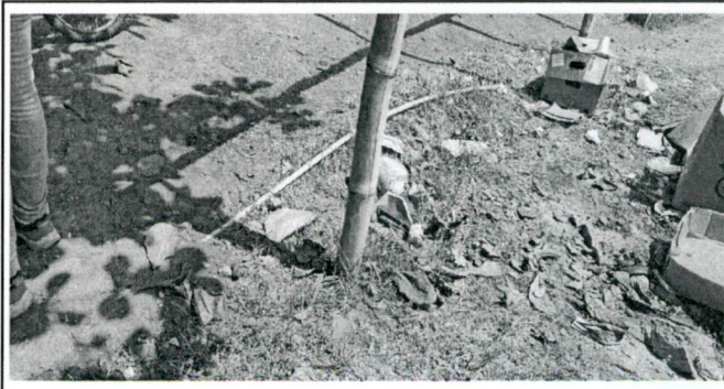
Sustitución de tubería de PVC de 1/2" para agua entubada
