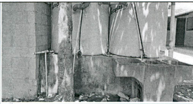
Sustitución de depósito de polietileno para agua y sustitución de pila de dos lavaderos
