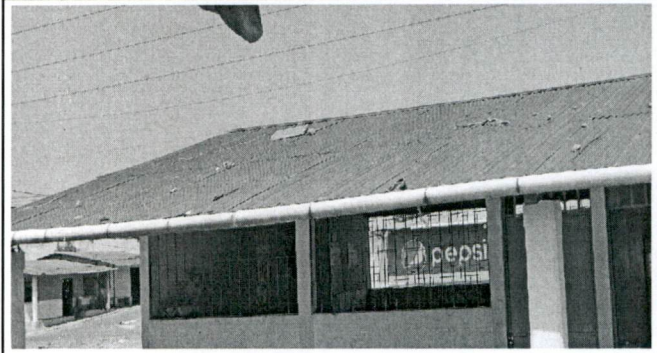
Sustitución de cubierta de lámina por lámina troquelada calibre 26 y sustitución de estructura de soporte de techo, susitución de canal de tubo PVC por canal de estructura metálica y bajadas de agua pluvial
