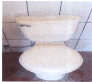
Foto 4: Sustitución de accesorios de inodoro.
