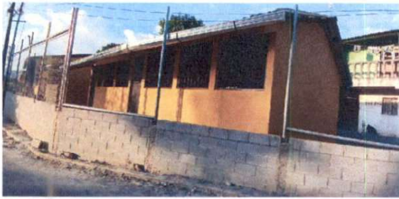
Foto 3: Sustitución de canal de pvc.
