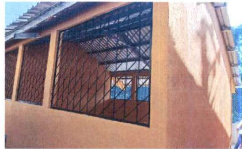
Foto 6: Reforzamiento de columnas y levantado de mojinete.
