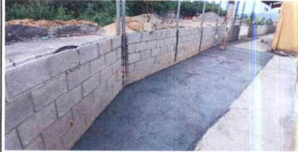
Foto 2: reparación de planchas de concreto, derivado a grietas que presentan.
