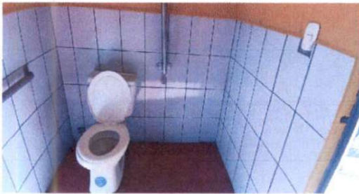
Foto 5: Instalación de azulejos en paredes de baños.
