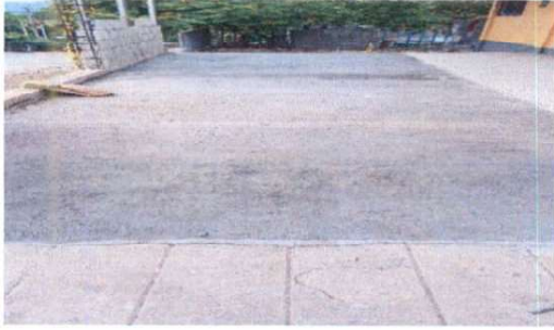
Foto 1: reparación de banqueta de concreto, derivado al deterioro de la actual.
