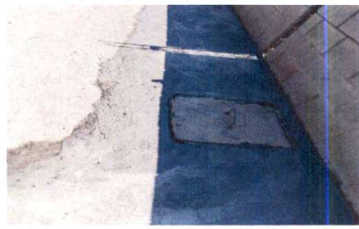
Foto 2: reparación de planchas de concreto, derivado a grietas que presentan.
