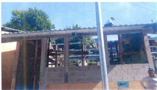
Foto 3: Sustitución de canal de pvc.
