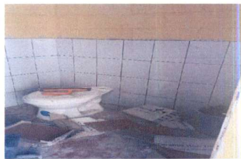
Foto 4: Sustitución de accesorios de inodoro.
