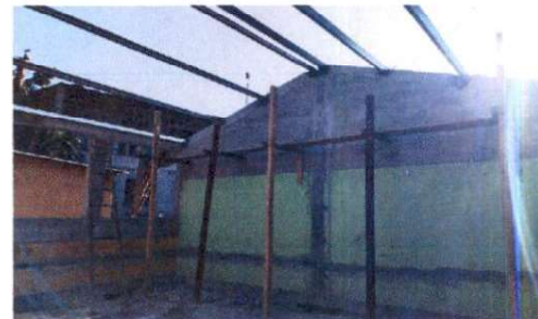
Foto 6: Reforzamiento de columnas y mojinete de aulas
