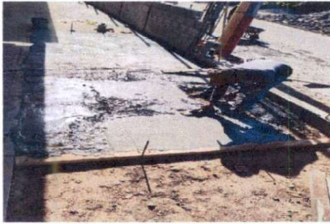
Foto 1: reparación de banqueta de concreto, derivado al deterioro de la actual.
