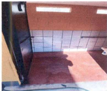
Foto 5: Instalación de azulejos en paredes de baños.
