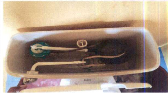
Foto 4: Sustitución de accesorios de inodoro.
