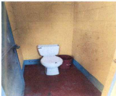
Foto 5: Instalación de azulejos en paredes de baños.
