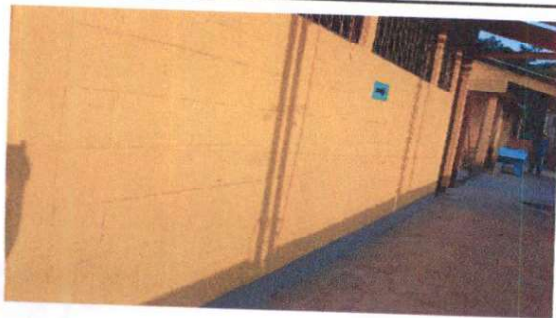
Foto 5: Aplicación de pintura en muros de exteriores
