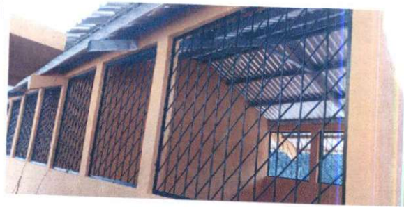
Foto 4: Sustitución de ventanas de madera por ventanas de metal.
