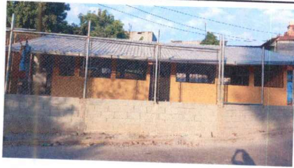
Foto1: Cambio de techo de lámina por lámina troquelada
