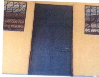
Foto 2: Cambio de puerta de madera por instalación de puerta de metal
