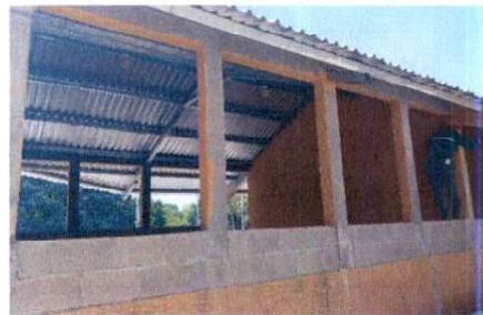
Foto 4: Sustitución de ventanas de madera por ventanas de metal.
