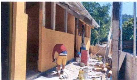
Foto 5: Aplicación de pintura en muros de exteriores
