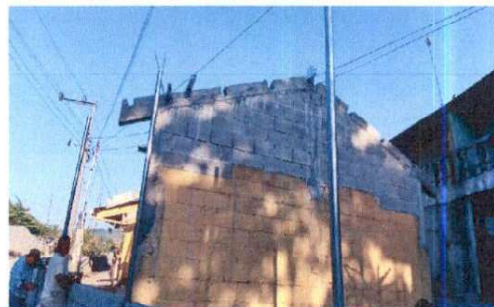
Foto 6: Reparación en el cableado eléctrico y sustitución de ducto eléctrico.
