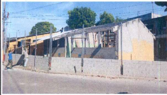
Foto1: Albañiles colocando lámina troquelada en las aulas.
