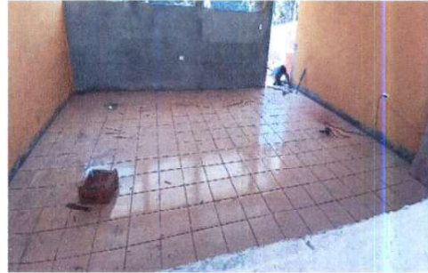
Foto 2: Cambio de puerta de madera por instalación de puerta de metal
