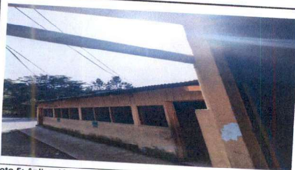
Foto 5: Aplicación de pintura en muros de exteriores
