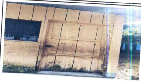
Foto 2: Cambio de puerta de madera por instalación de puerta de metal
