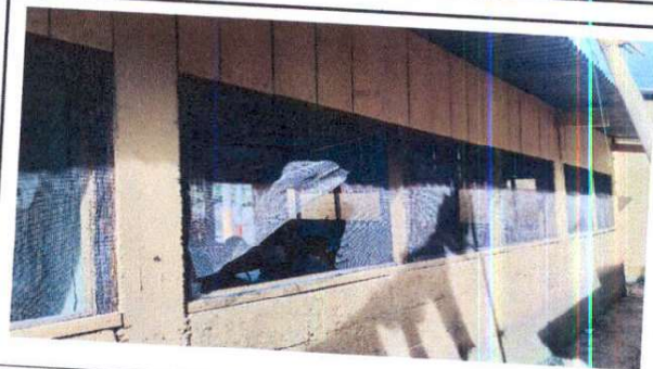
Foto 4: Sustitución de ventanas de madera por ventanas de metal.
