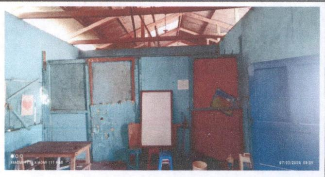
Sustitución de divisiones de plywood por paredes de block, sustitución de pertas de madera por metal.
