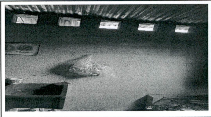
Sustitución de lámina por lámina troquelada calibre 26
