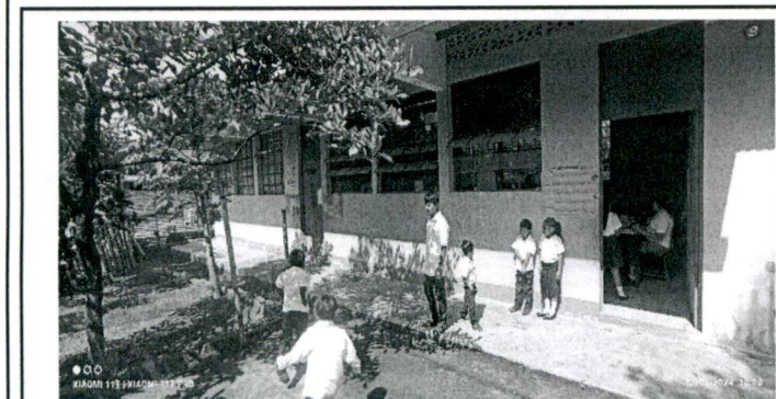
Pintura en muros interiores y exteriores
