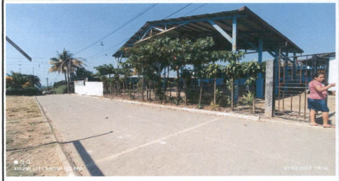
Sustitución de malla galvanizada por muro de block
