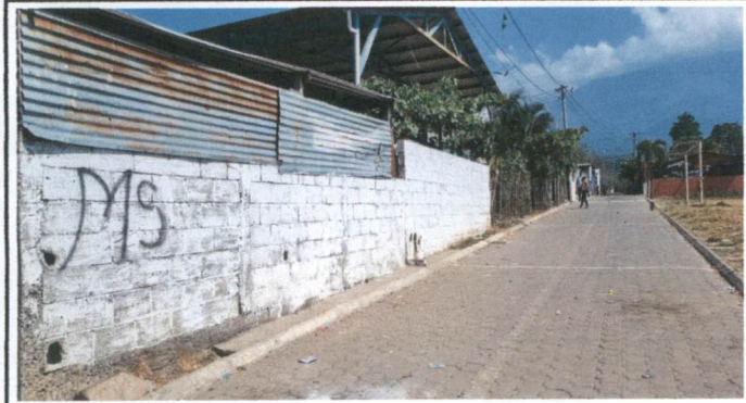
Sustitución de malla galvanizada por muro de block
