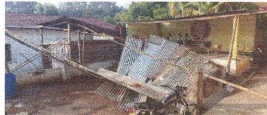
Foto 6: FOTOGRAFIA ESTADO ACTUAL DE LA LAMINA DEL ESCENARIO, SE CAYÓ A CAUSA DEL VIENTO
