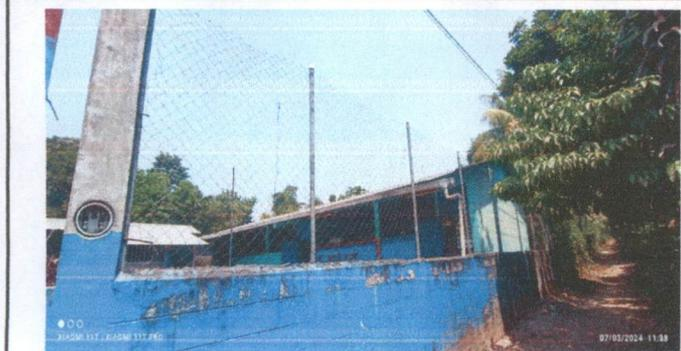
Sustitución de malla galvanizada por levantado de muro de mampostería de block.
