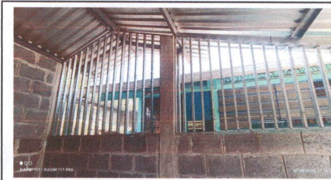
Instalación de tela metálica en ventanas, repello y cernido en paredes y aplicación de pintura
