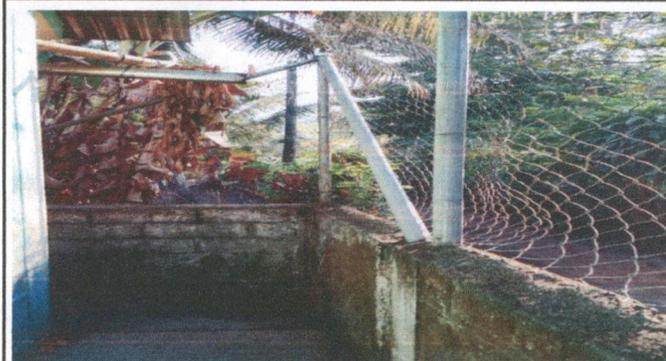
Sustitución de malla galvanizada por levantado de muro de mampostería de block.
