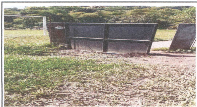
Sustitución de malla galvanizada por pared de mampostería de block
