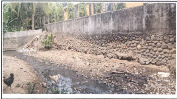
Sustitución de muro de contención socavado y muro perimetral, incluye repello y cernido
