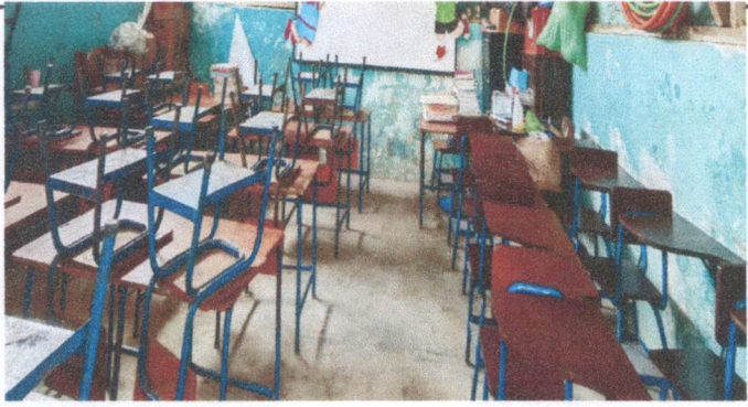
Sustitución de piso de concreto por piso cerámico en aulas.
