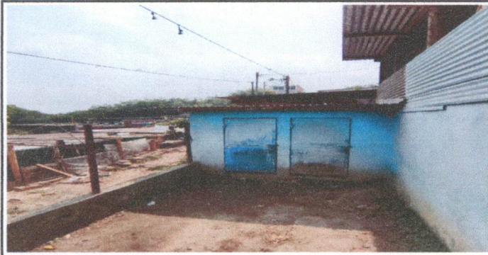
Cambio de cubierta de lamina a lámina troquelada calibre 26
