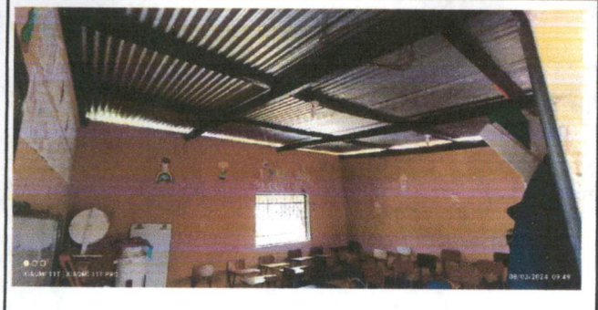
Sustitución de lamina por lamina troquelada y sustitucion de estructura de madera por metal en módulo de aulas
